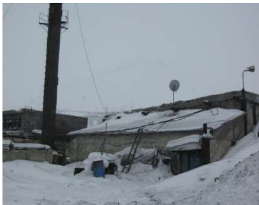
Фото 1. Здание угольной котельной.
